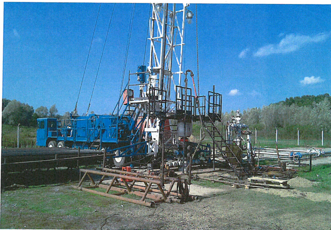
Slika 5. Remontni radovi na bušotinama
